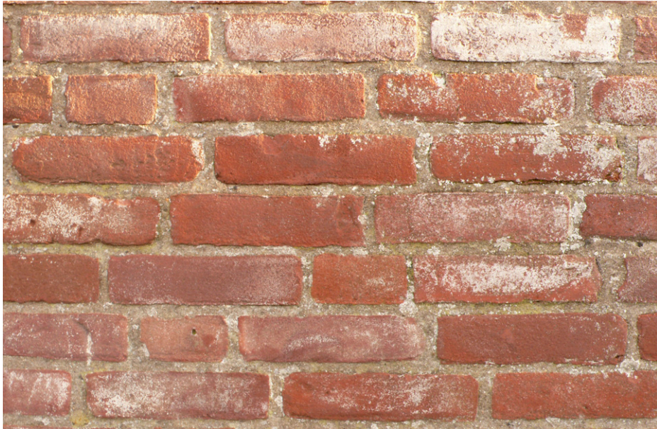
Metselwerk in 'wild verband'
