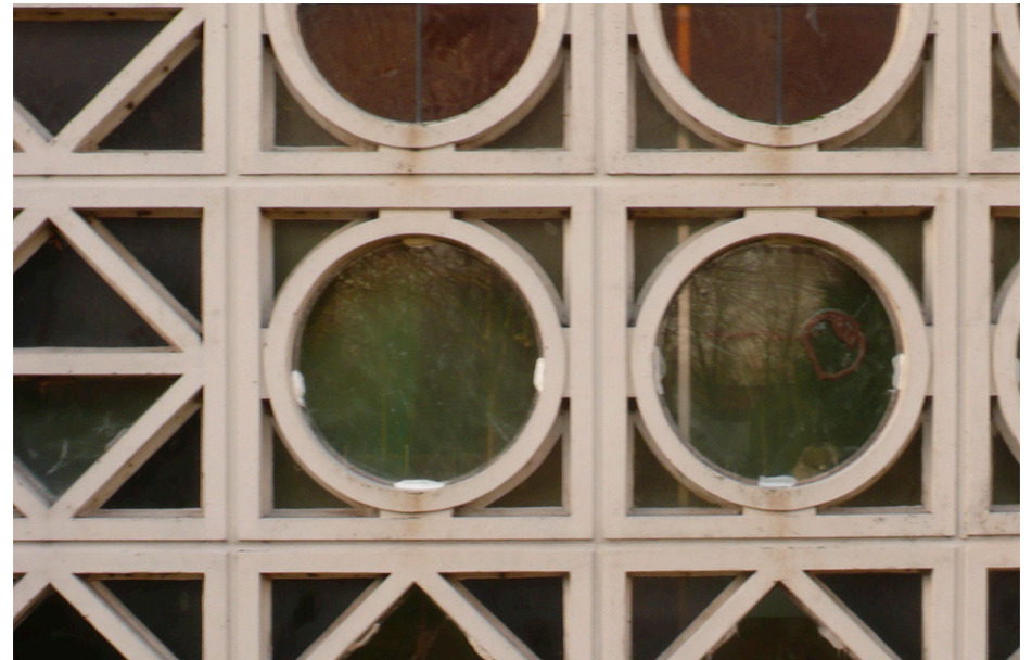
Betonelementen gevuld met gekleurd glas
