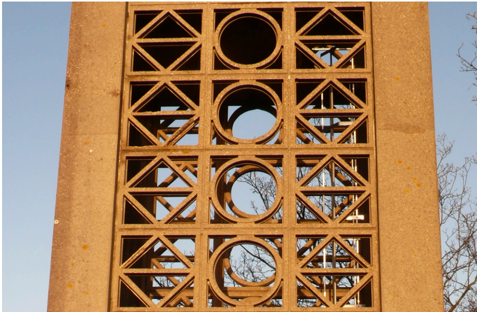
Open betonelementen in de toren
